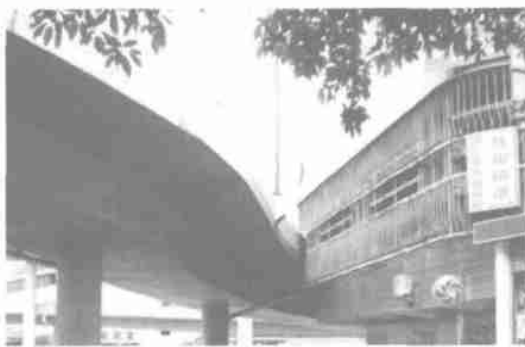
图 3 高架桥与建筑物紧挨在一起(广州) Fig. 3 Viaduct bridge contact with a building (Guangzhou)
