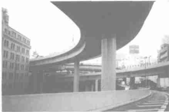
图 2 日本东京的多层立体交通道路 Fig. 2 Multi-level viaducts in Tokyo
